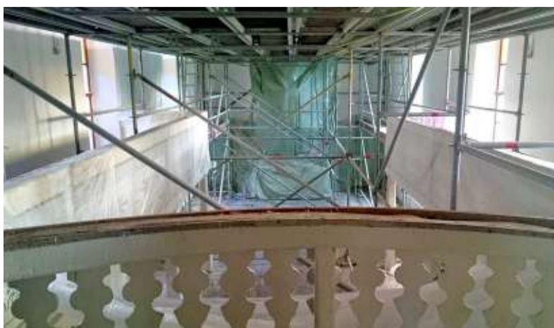
So sah der Innenraum der Kirche Krina vor der Sanierung aus.
