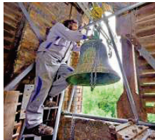
Seilzüge und Hilfskonstruktionen sind für den sicheren Ausbau nötig.
